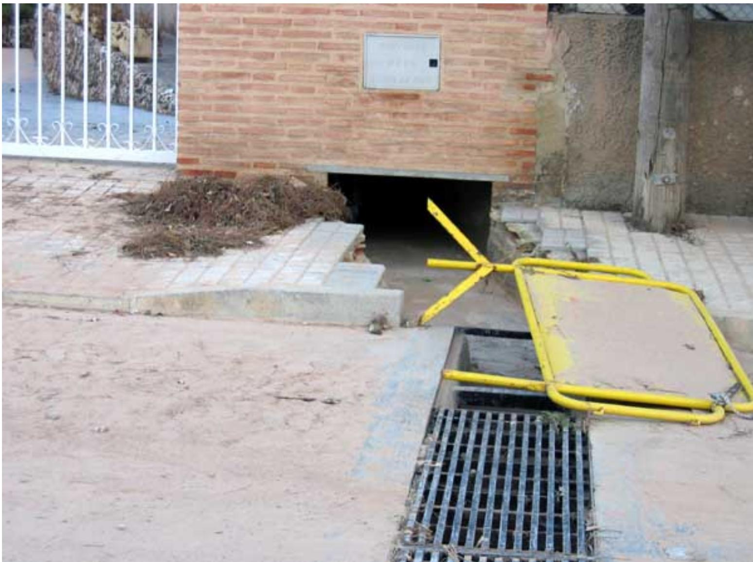
El canal de desagüe es ancho pero también tiene un defecto. En la siguiente foto la flecha roja indica el sentido de desagüe entrando al canal que atraviesa la parcela. Se ve un escalón que reduce la profundidad del canal de desagüe. El agua que el imbornal no tira al canal se la "reparten" los vecinos.
