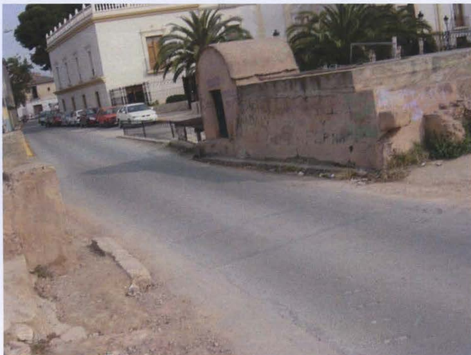
FOTOGRAFIA 1 creuament carrer Major amb Reial Séquia de Moncada
