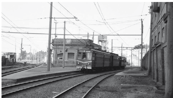
Antigua estación de "Empalme" años 80. Fondos Archivo Histórico FGV
