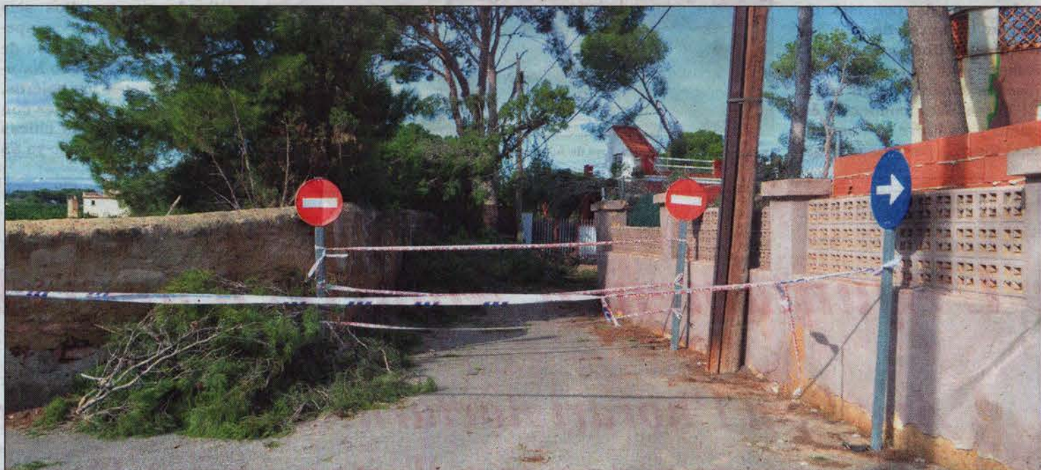
Daños ocasionados por el temporal de agua y viento del lunes en distintas zonas de Moncada, como el barrio de Masías o el casco urbano. //EPDA
