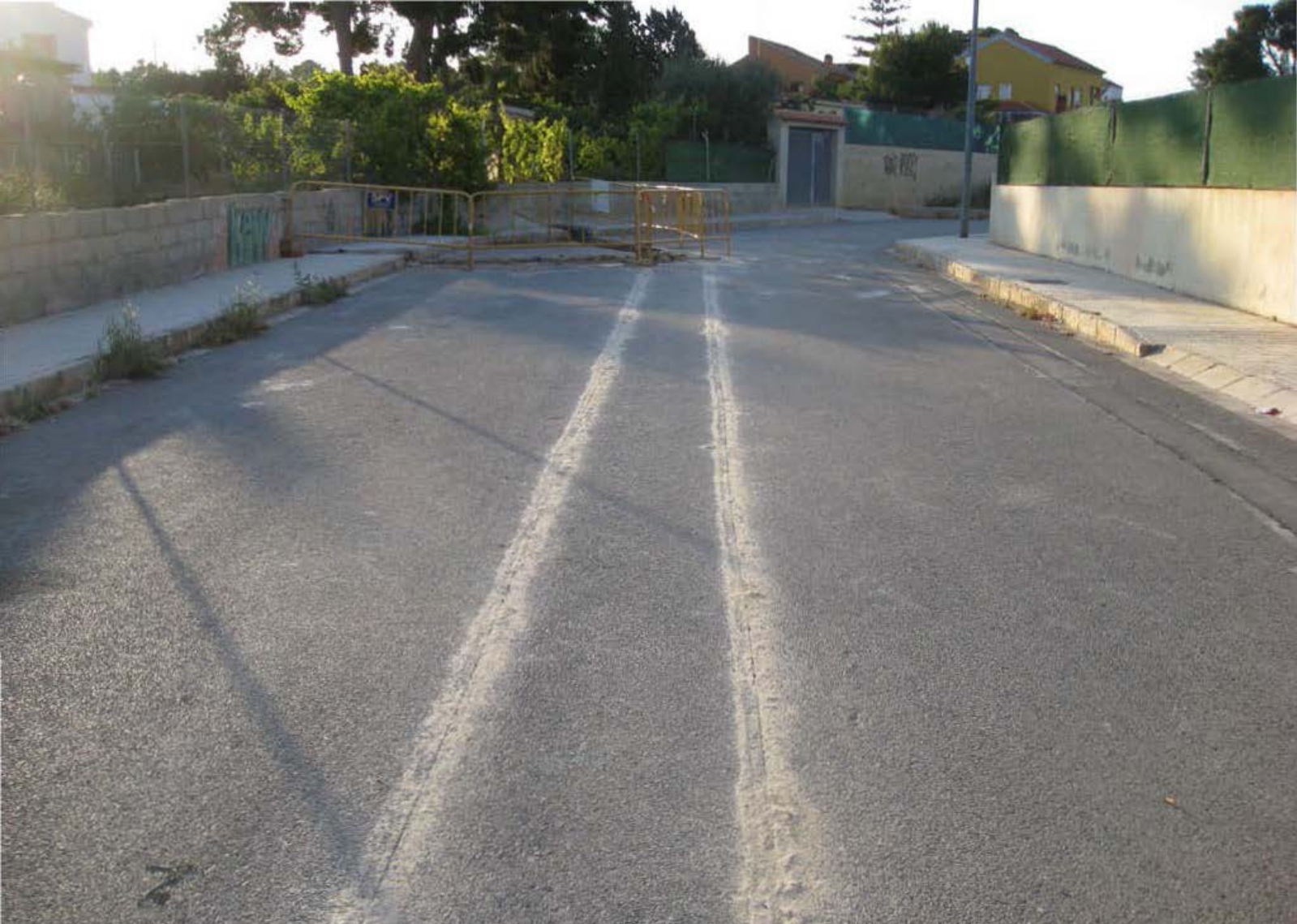
Acometidas en la calle 170 hasta un futuro pozo de registro y trazado de la canalización.
