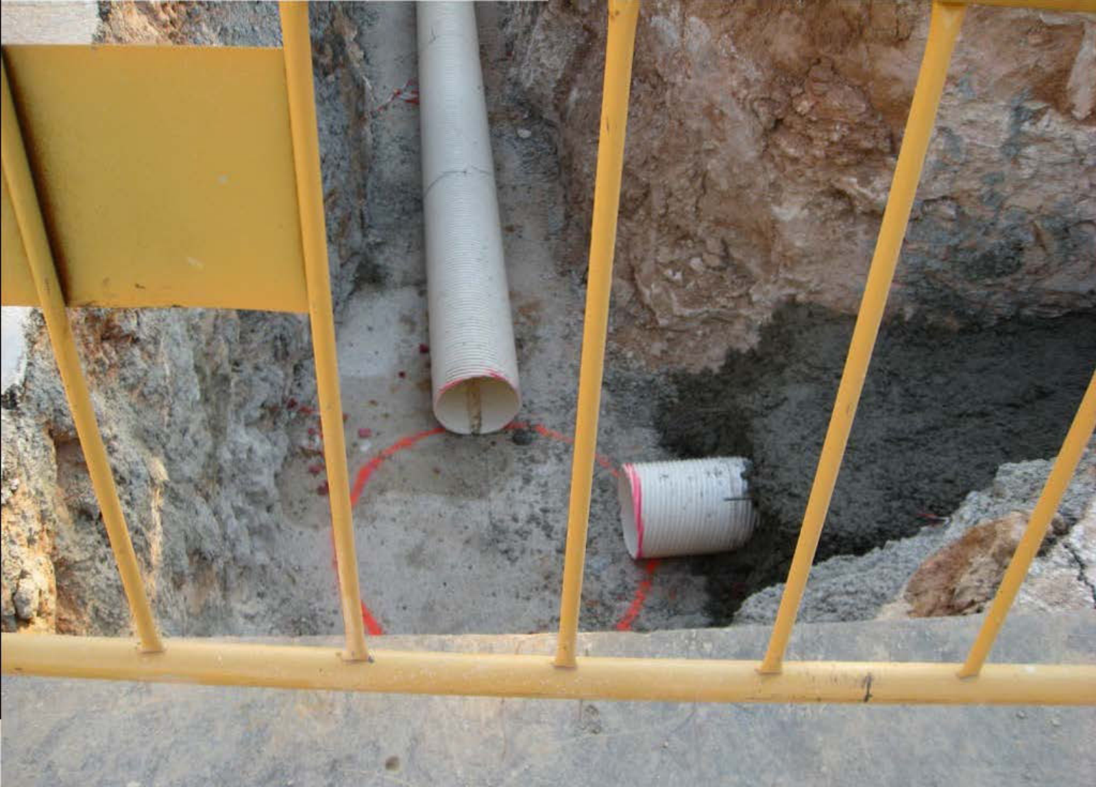
Tubitos de alcantarillado en el cruce de las calles 145 con 134.
