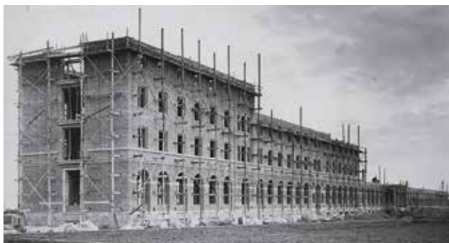
Seminario de la Purísima en construcción
