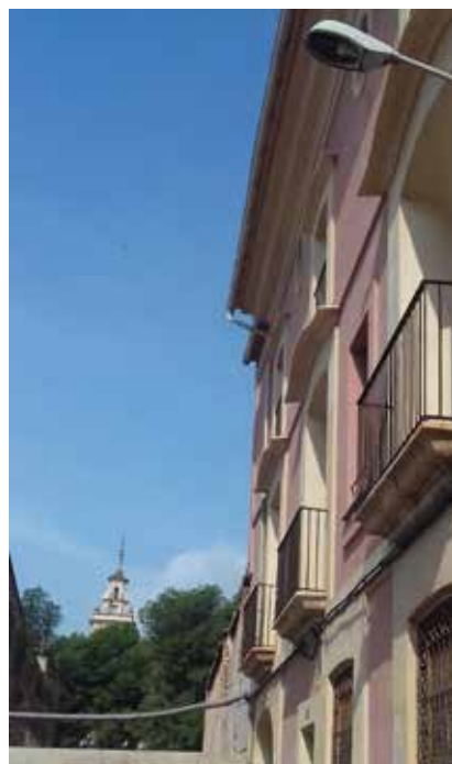
Fachada principal de la denominada “Finca Roja” o de los Gavarrots (siglo XVIII)
